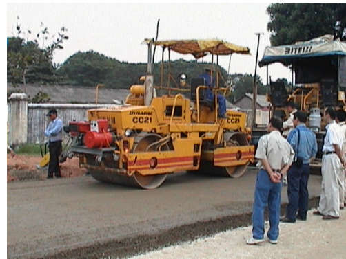
Hình 7 – Thi công thử nghiệm mặt đường BTĐL - IBST thực hiện 2001
