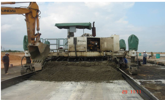
Hình 6 – Máy rải bê tông liên hợp SP- 500 thực hiện công tác đầm và xoa hoàn thiện (ACC)
