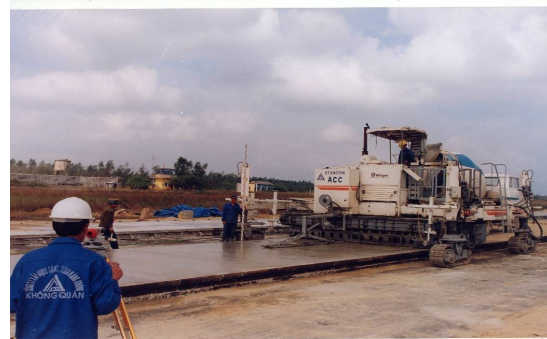
Hình 6 – Máy rải bê tông liên hợp SP- 500 thực hiện công tác đầm và xoa hoàn thiện (ACC)
