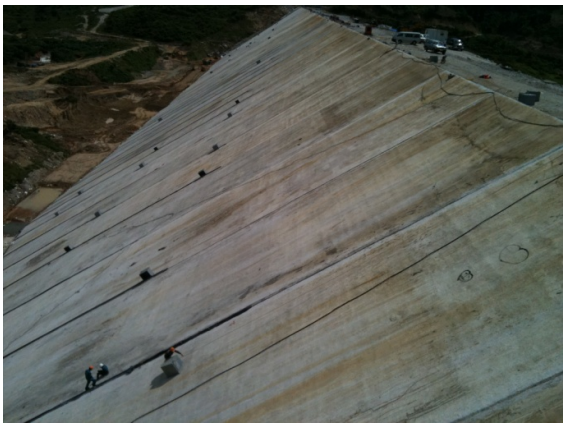
Hình 10.4. Thi công đập CFRD Đập An Khê - Kanak
