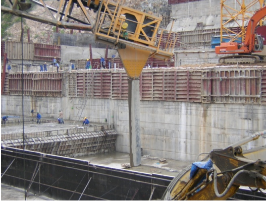
Hình 10.3. Sản xuất và đổ bê tông bằng băng tải tại đập CVC Sesan 3.
