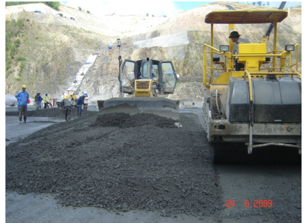
Hình 10.2. Thi công RCC đập thủy điện Đồng Nai 4 (Đắc Nông)
