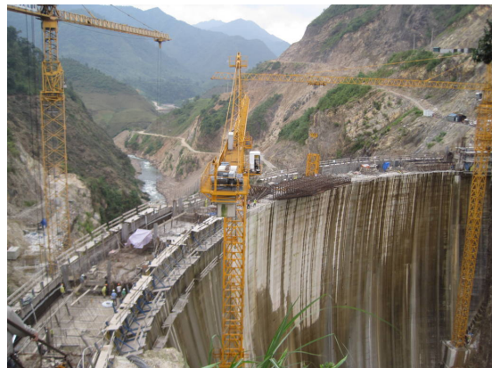
Hình 10.5. Thi công đập vòm cong 2 chiều Nậm Chiến
