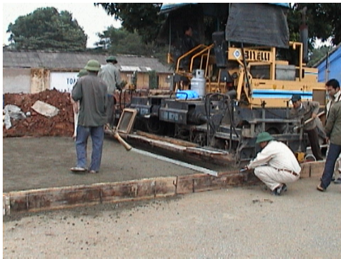
Hình 7 – Thi công thử nghiệm mặt đường BTĐL - IBST thực hiện 2001
