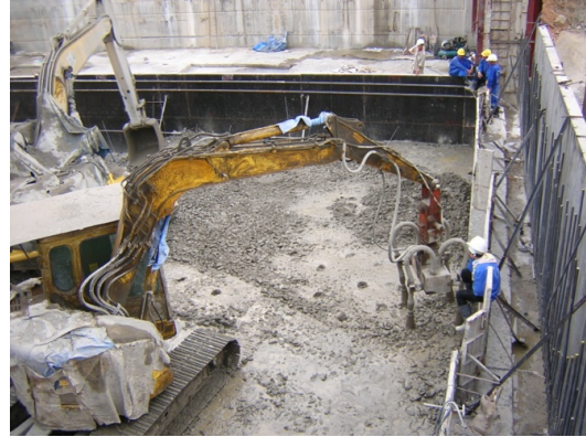
Hình 10.4. Đầm bê tông bằng đầm rung chuyên dụng tại đập CVC Sesan 3.
