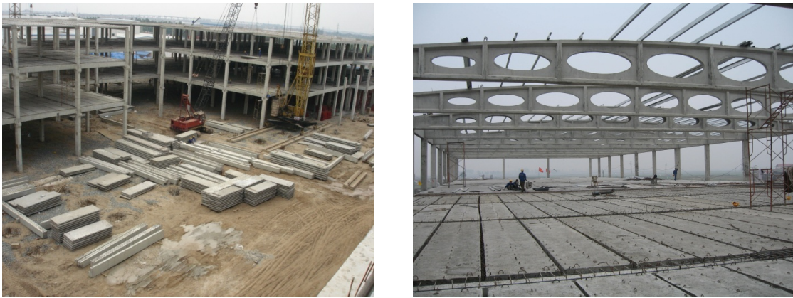
Hình 8. Ứng dụng BTLG trong công xây dựng nhà công nghiệp (Vinaconex)
