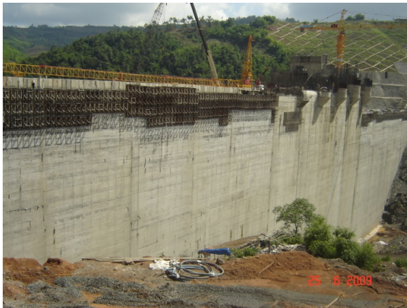
Hình 10.1 Xây dựng đập RCC thủy điện Đồng Nai 3 (Đắc Nông)
